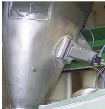
Čištění stěn jímek
